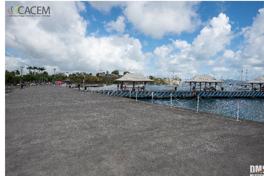
Ponton des navettes maritimes – pointe Simon à Fort-de-France
